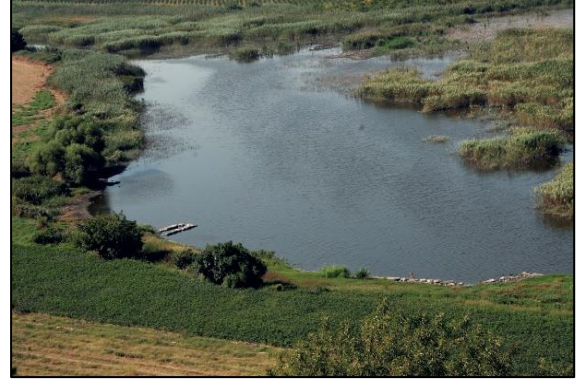
Resim 30. Ephesos Limanı'nın Güneybatıdaki İskelesine Ait Rıhtım Duvarları
