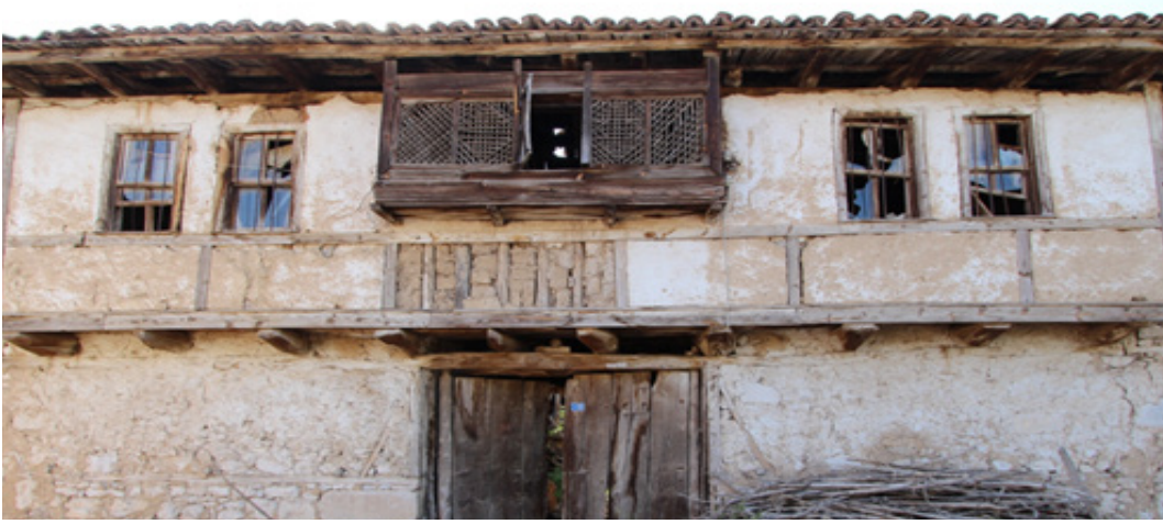
Fotoğraf 6: A13.ST.SM30 Envanter Numaralı Evin Cumbasındaki Ahşap Kafes (Ekmekci, 2013)
