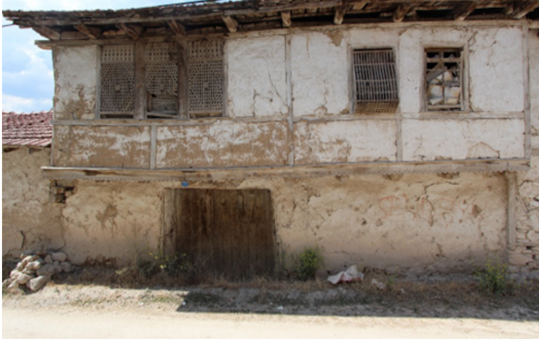
Fotoğraf 4: : A13.ST.SM01 Envanter Numaralı Evin Pencerelerindeki Ahşap Parmaklık (Ekmekci, 2013)
