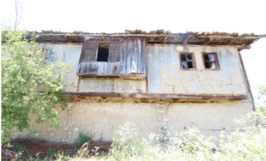
Fotoğraf 5: A13.ST.SM10 Envanter Numaralı Evin Cumbasındaki Ahşap Kafes (Ekmekci, 2013)
