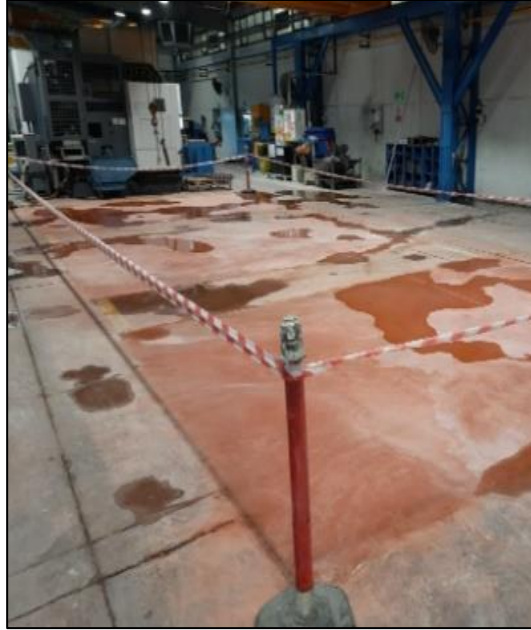
Şekil 4.24: Tezgâh zemin yapılması
