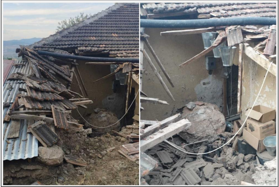
Şekil 71. Aşağıdadhare'de taş ocaklarından yuvarlanarak gelen kaya bloklarının zarar verdiği bir ev (Url 12)
