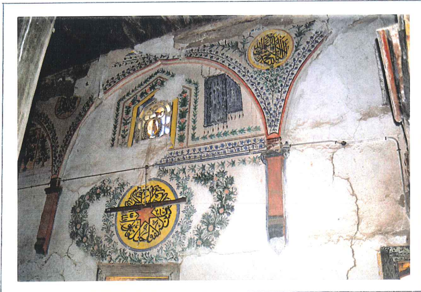
3.2.21.Batı Cephesinin Orta Bölümü
