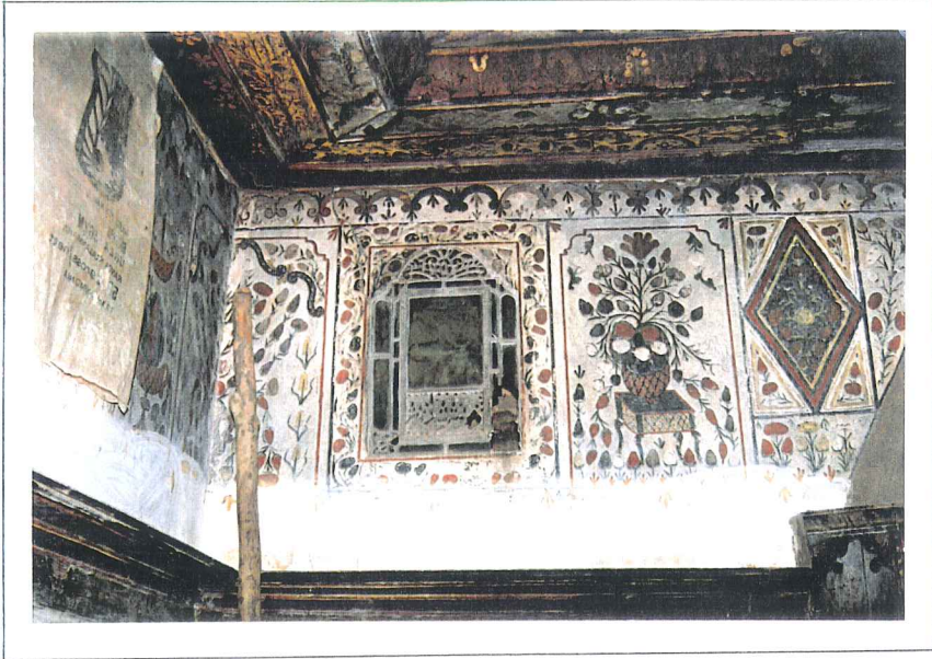
3.4.17. Odanın Batı Cephesinin İlk Penceresi
