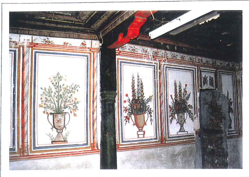
3.3.30. Kuzeydoğu Üst Cephesi
