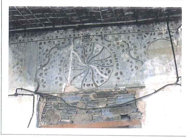
3.4.7. Yapının Yıkılan Üst Odanın Üzerindeki Motif
