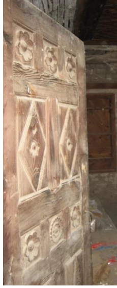
Foto. 11. Konyalıođlu Evi, Restorasyon Öncesi Zemin Kat Dođu Kapısı. (Denizli B.Şehir Belediyesinden)
