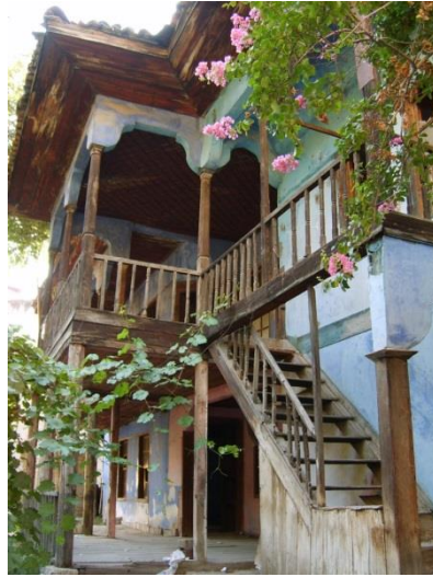
Foto. 5. Konyalıođlu Evi, Restorasyon Öncesi Avluya Bakan Cephesi, (Denizli B.Şehir Belediyesinden)
