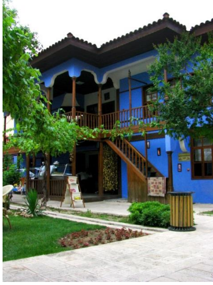
Foto. 6. Konyalıođlu Evi, Restorasyon Sonrası Avluya Bakan Cephe. (Murat Dađdelen)
