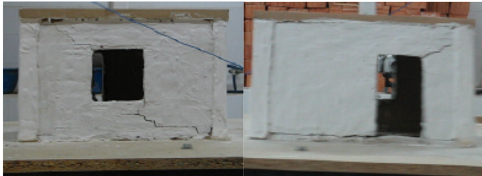
Sekil 4.20 HÇGN1 numunesinde hasar durumu
