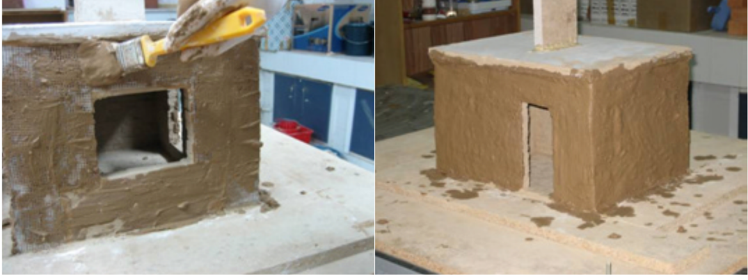
Sekil 4.5 Duvarın sıvanması
