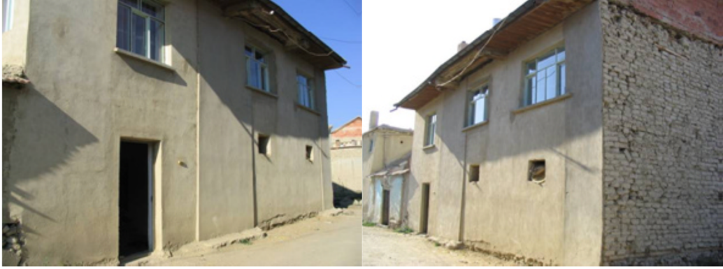
Sekil 4.15 Akşehir’de kerpiç yapıların hasır çelik ve siva ile güçlendirilmesi
