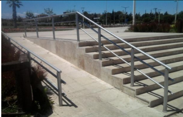
Merdiven ve Rampa (35).
