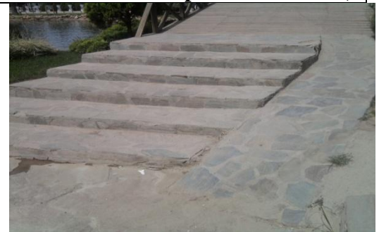
Merdiven ve Rampa (22).
