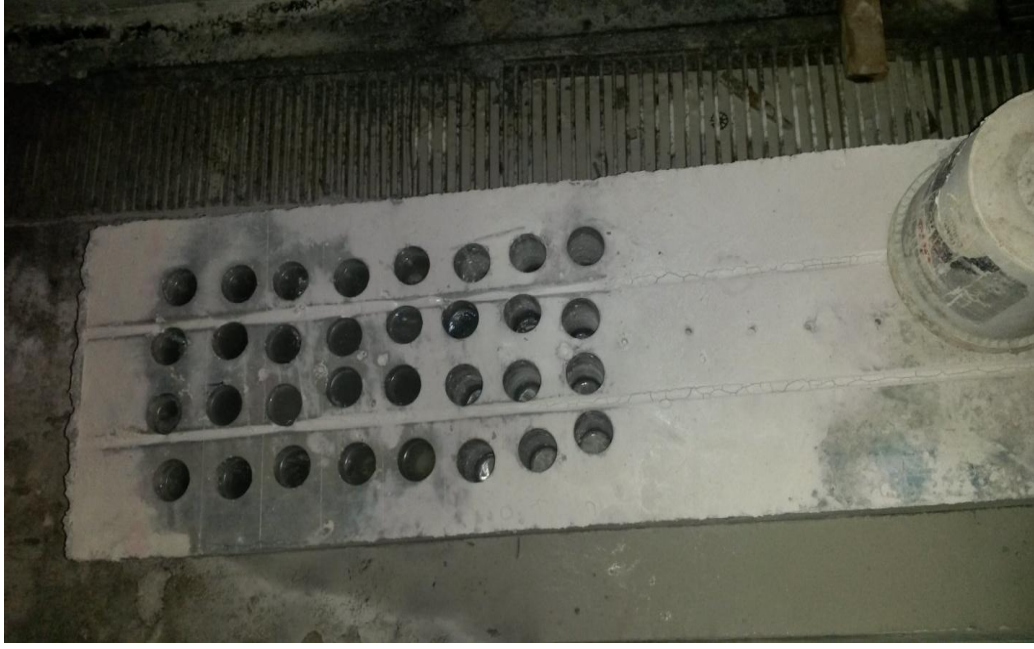
Şekil 3.10: Beton karot numunesi alınan kolon
