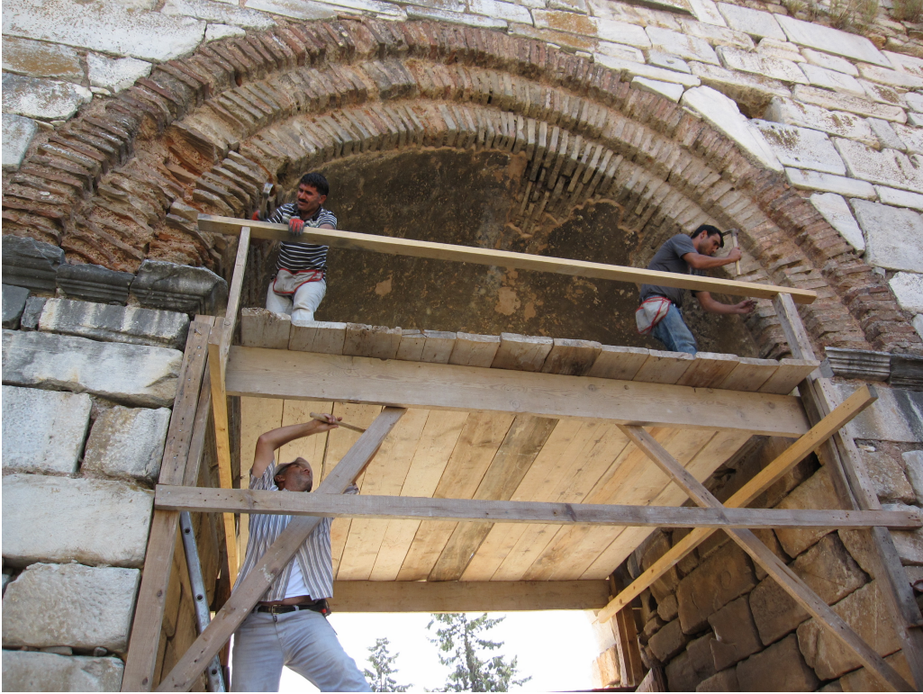
Resim 18: Takip Kapısı içine fresklerin temizliği için kurulan iskele (2012)
