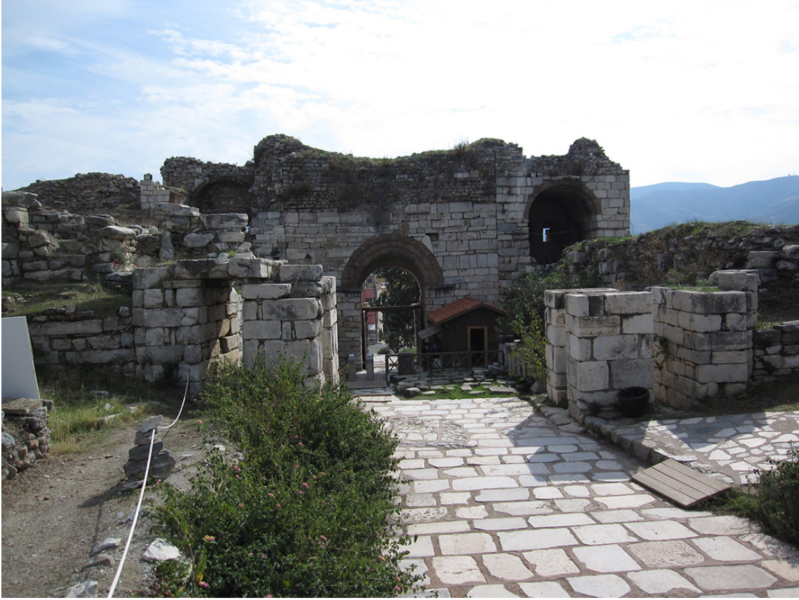
Resim 8: Takip Kapısı, Kuzey Cephe (2012)
