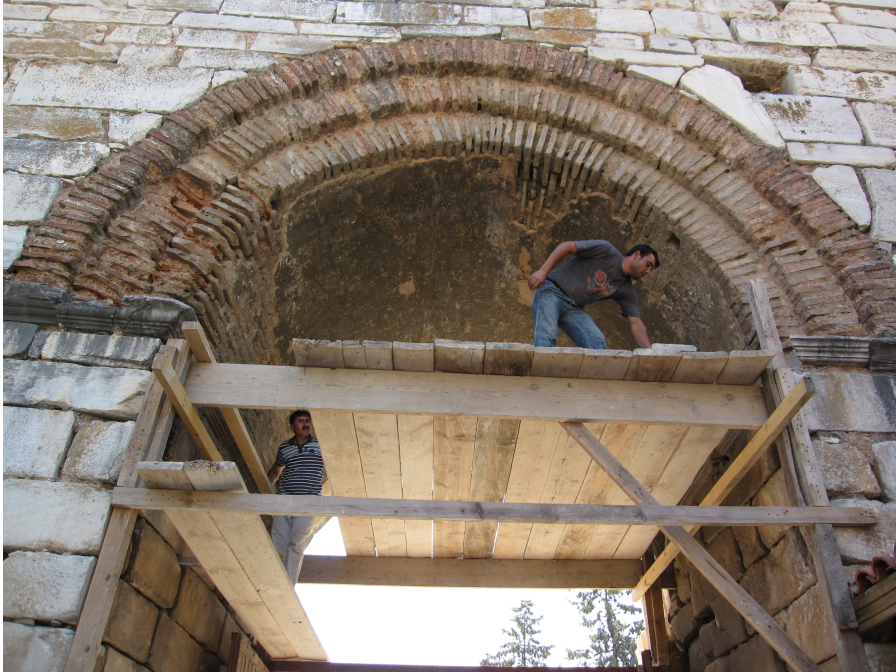
Resim 17: Takip Kapısı içine fresklerin temizliği için kurulan iskele (2012)
