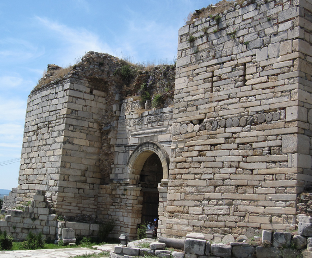
Resim 6: Takip Kapısı, güneydoğudan (2012)
