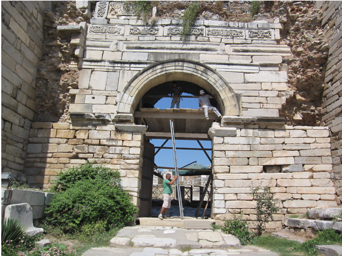
Resim 19: Takip Kapısı içine fresklerin temizliği için kurulan iskele (2012)
