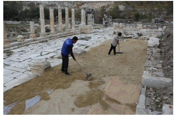
Figür 112: İnce Dere Kumunun Örtü Üzerine Serilmesi
