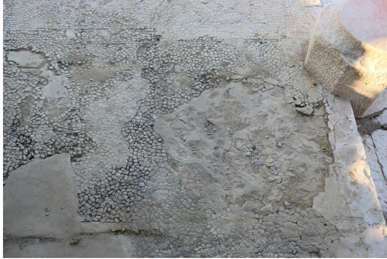
Figür 95: 3 Nolu Panel Uygulama Öncesi Genel Görünüm
