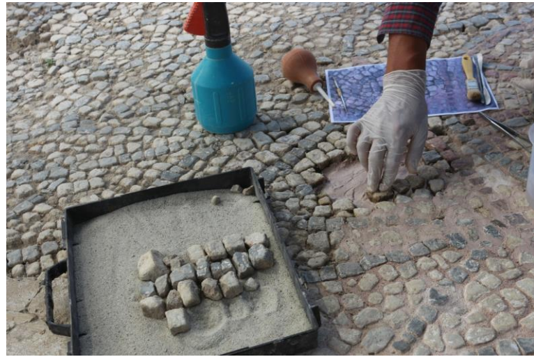
Figür 78: Yatak Harcı Yenilenen Tesseraların Yerlerine Sabitlenmesi
