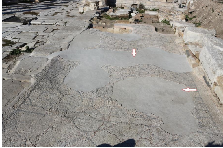
Figür 94:1 Nolu Panel Lakuna Dolgu Çalışmaları Sonrası
