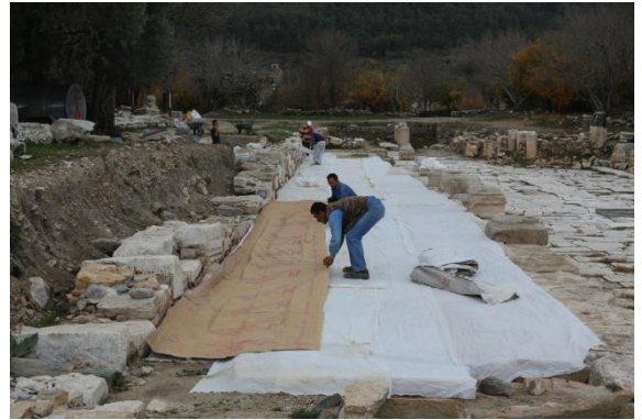
Figür 110: Jeotekstil ve Jeotermal Örtünün Mozaik Yüzeyine Serilmesi
