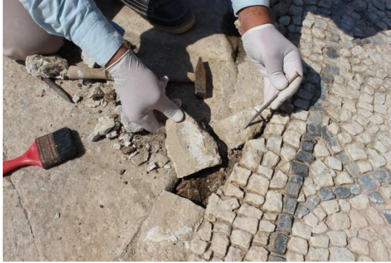
Figür 57: Hasarlı Olan Eski Onarım Harçlarının Temizlenmesi
