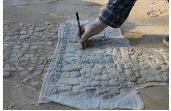
Figür 70: Kaldırılacak Alanın İşaretlenmesi
