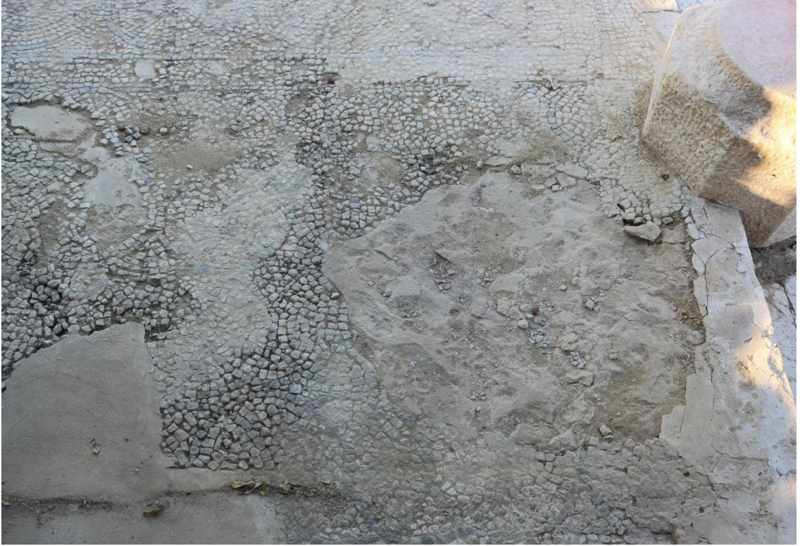
Figür 18: 3 Nolu Panel Harç Yatağından Ayrılmış Tesseralar
