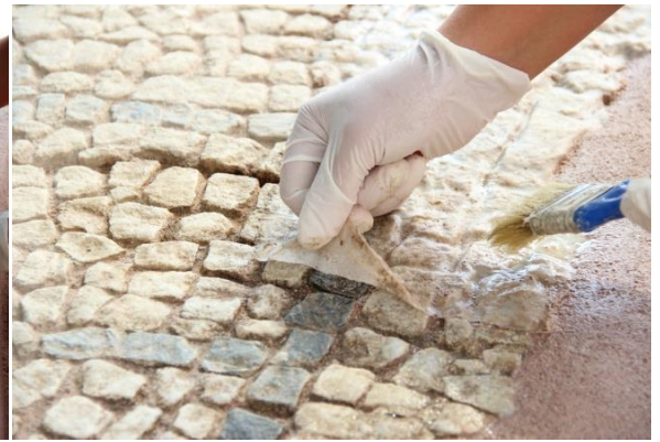
Figür 54: Çözünen PB 72'li Bezin Kaldırılması ve Temizlenmesi.
