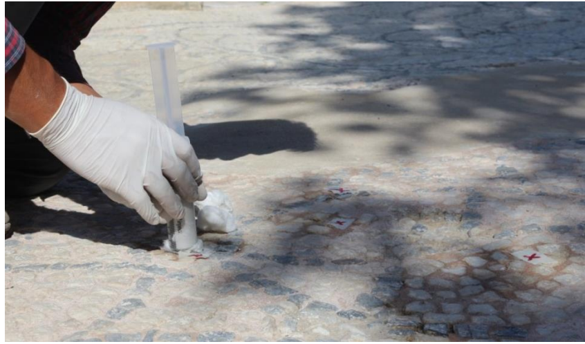
Figür 62: Enjeksiyon Yöntemi ile Mozaik Sağlama Çalışması.
