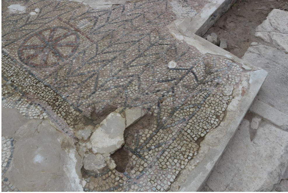
Figür 90: Uygulama Sonrası Genel Görünüm
