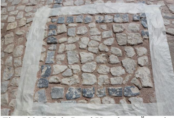
Figür 39: 7 Nolu Panel Uygulama Öncesi Genel Görünüm
