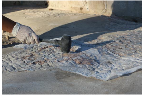
Figür 75: Kapama Sonrası Plastik Tokmak ile Seviye Düzeltme
