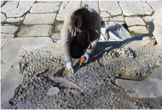
Figür 88: Tessera ile Tamamlama ve Temizlik Çalışmaları
