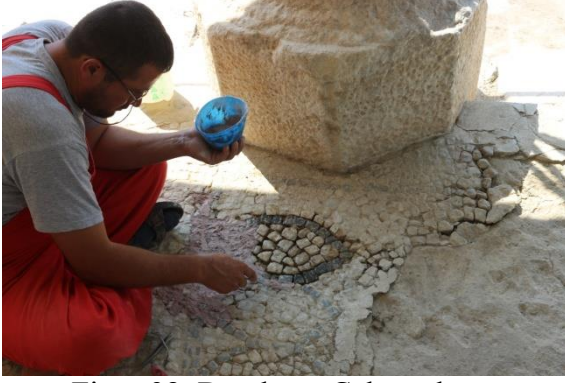
Figür 98: Derzleme Çalışmaları
