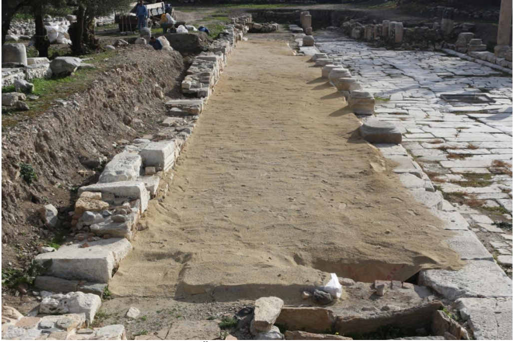
Figür 113. Geçici Koruma Örtüsü ile Kapatma Sonrası Genel Görünüm
