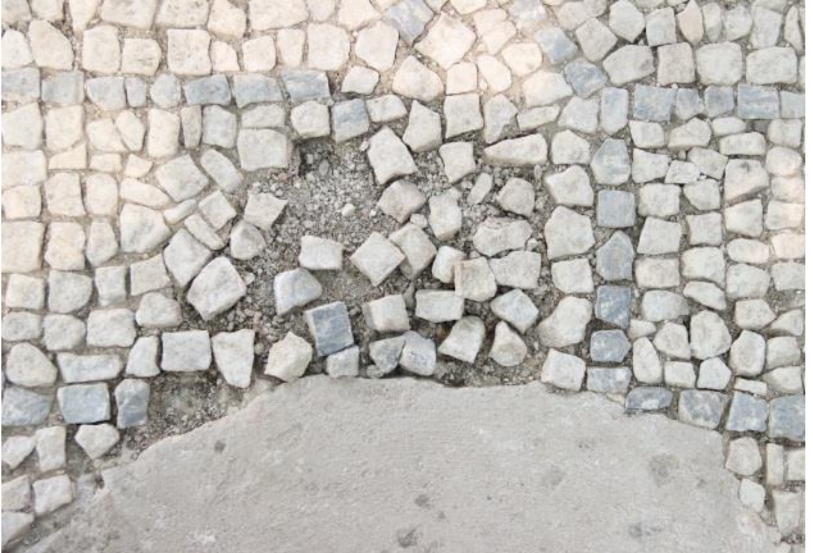
Figür 19: 1 Nolu Panel Harç Yatağından Ayrılmış Tesseralar
