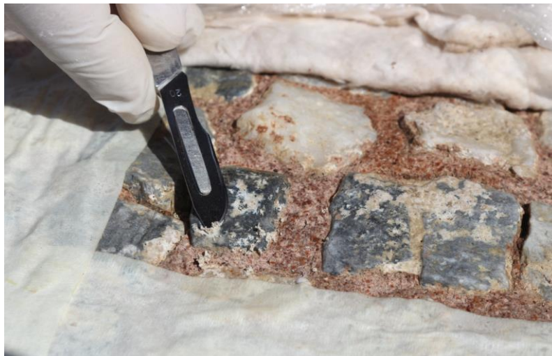
Figür 42: Yumuşayan Kalker kalıntılarının Bistüri ile Temizlenmesi
