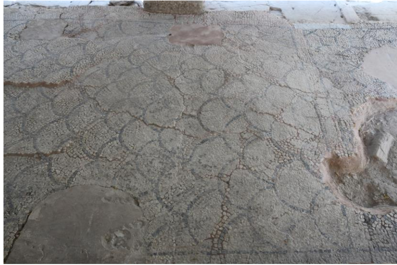
Figür 82: Uygulama Sonrası Genel Görünüm
