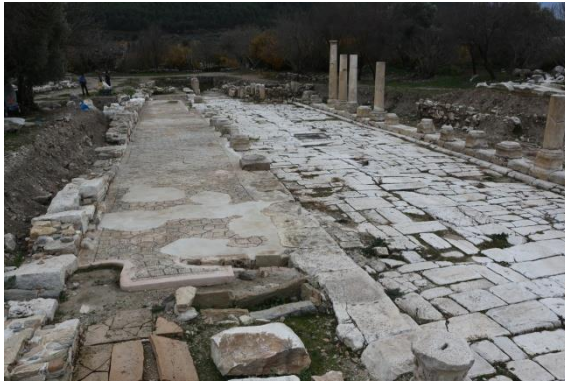
Figür 109: Uygulama Öncesi Genel Görünüm
