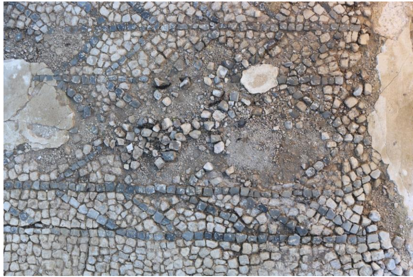
Figür 83: Uygulama Öncesi Genel Görünüm
