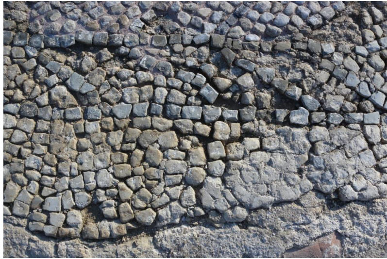
Figür 66: Uygulama Sonrası Genel Görünüm
