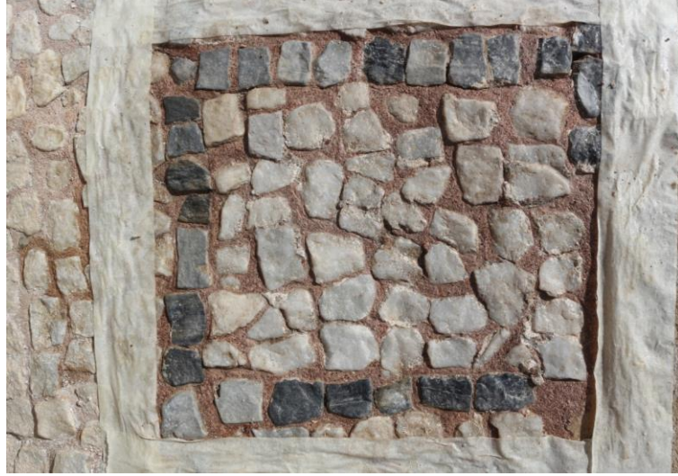
Figür 43: Uygulama Sonrası Genel Görünüm
