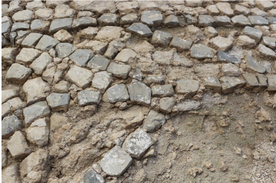
Figür 63: Uygulama Öncesi Genel Görünüm
