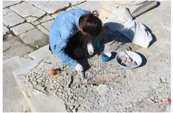
Figür 87: Tesseraların Onarım Harcı ile Yatağına Sabitlenmesi
